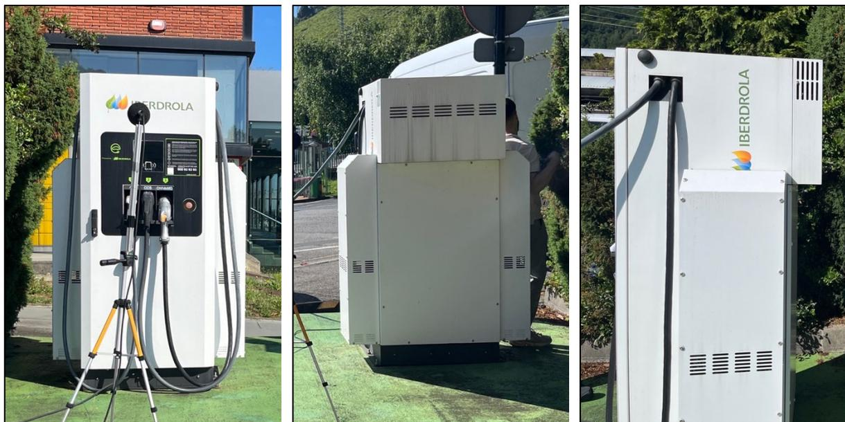
**Figura 9:** Estación de carga rápida Ingeteam Rapid 50 kW con un dispositivo de amortiguación sonora.
