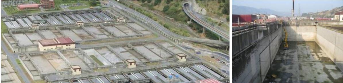
**Figura 3:** Balsas de tratamiento biológico y detalle de una balsa vacía.
