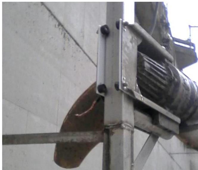
**Figura 7:** Detalle del posicionamiento del agitador
